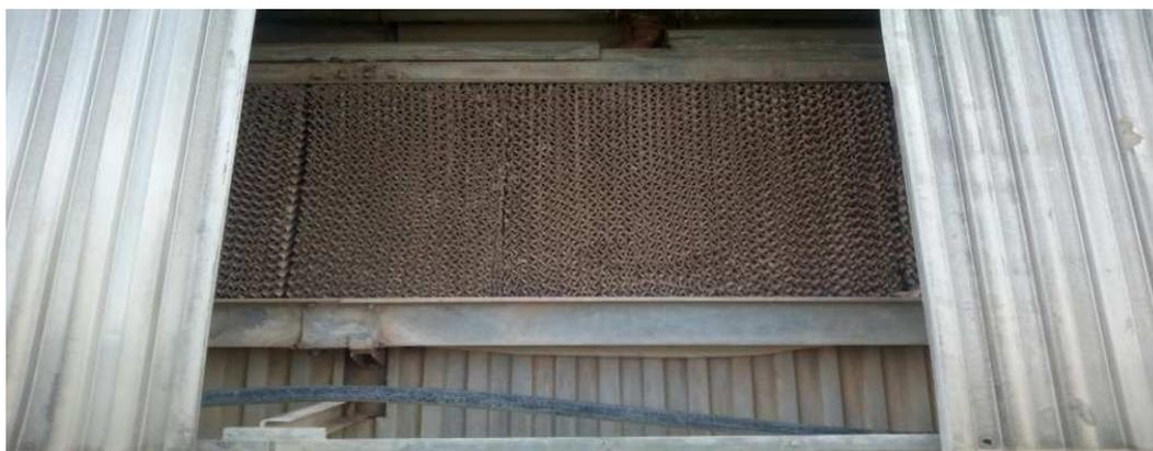
**Figure 9** : Système de refroidissement du bâtiment (*pad cooling*), (photo personnelle, 2017).
