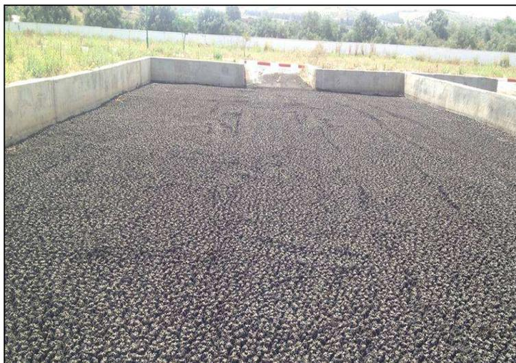
**Figure 9 : Lit de séchage des boues. (Originale)**
