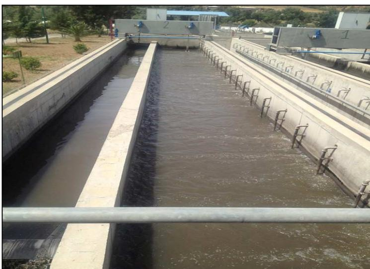
**Figure 7 :** Déshuilage des eaux au niveau de la station d'épuration d'Oued D'hous de Bouira. (Originale)
