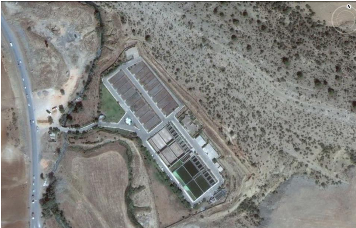
Figure 04 : situation de la station d'épuration de SOUR EL GHOZLANE . (Google Earth 2017)
