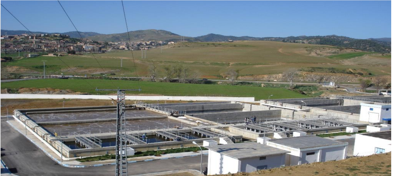
Photo 01 : La station d'épuration des eaux usées de Sour El GHOZLANE (ONA) .(photo originale Mayouf/Boutrig)
