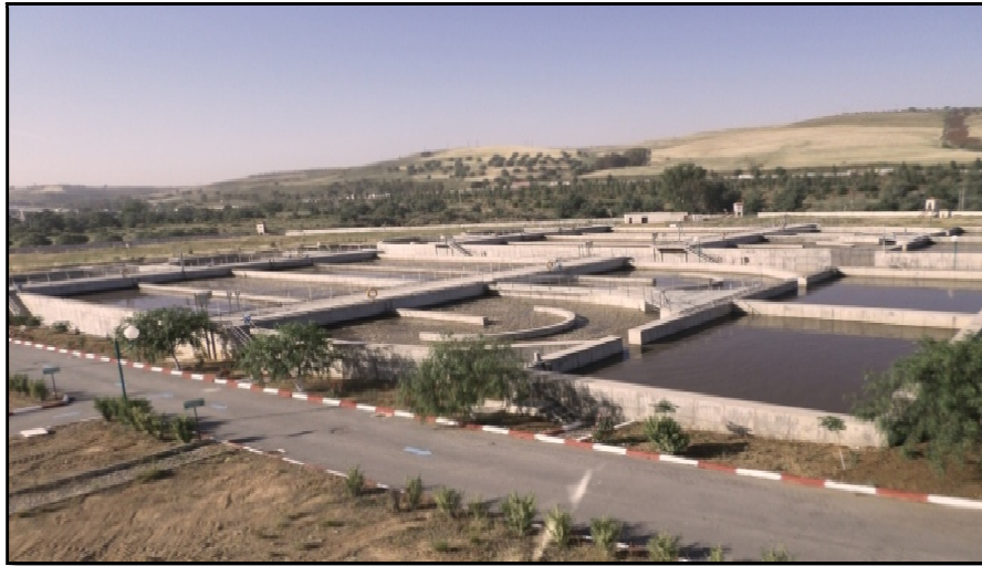
Figure 08 : Bassins d'aération (source : auteur)
