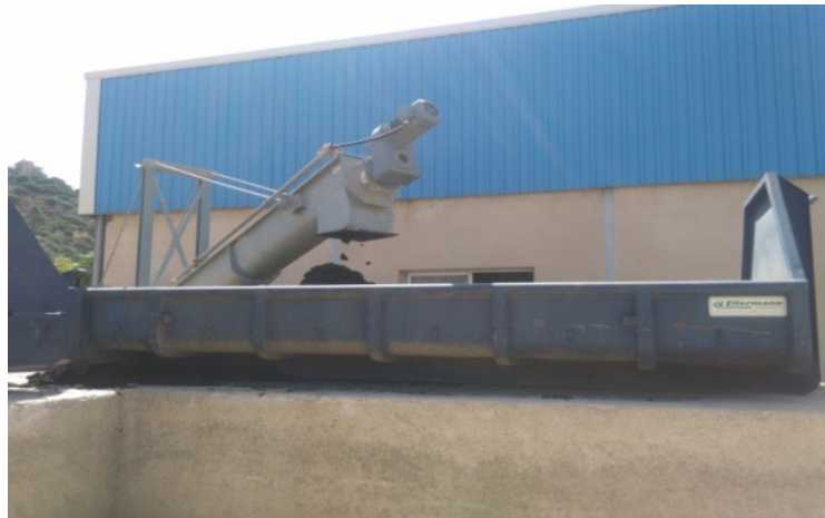
Figure 32: Boue issue de la déshydratation mécanique (source : Auteur).
