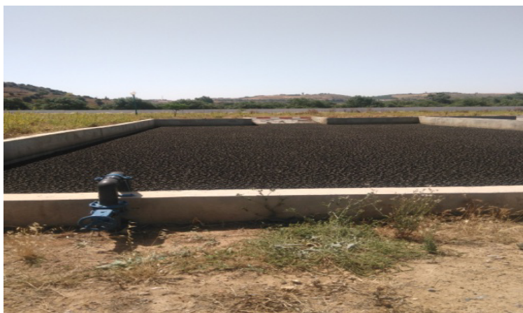
Figure 33 : Lits de séchage (source : Auteur).
