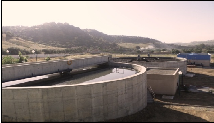
Figure 10 : Epaississeur (source : auteur)
