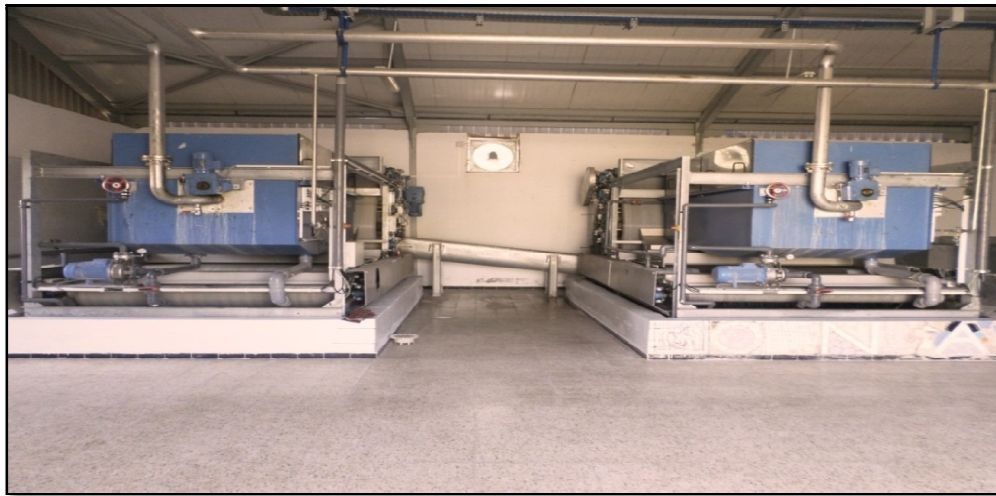
Figure 11: Déshydratation mécanique (source : auteur)
