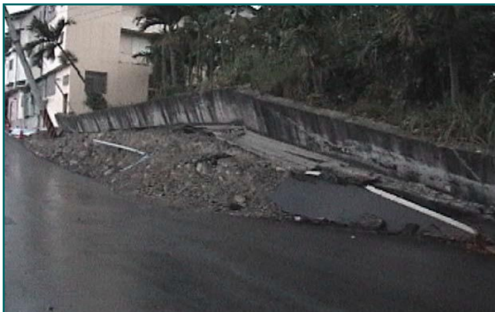
Figure 3 : Mur élevé par décrochement de faille, déplacement vertical et horizontal de 2.0m et 1.3m respectivement (séisme de Chi-Chi Taiwan (1999)).
