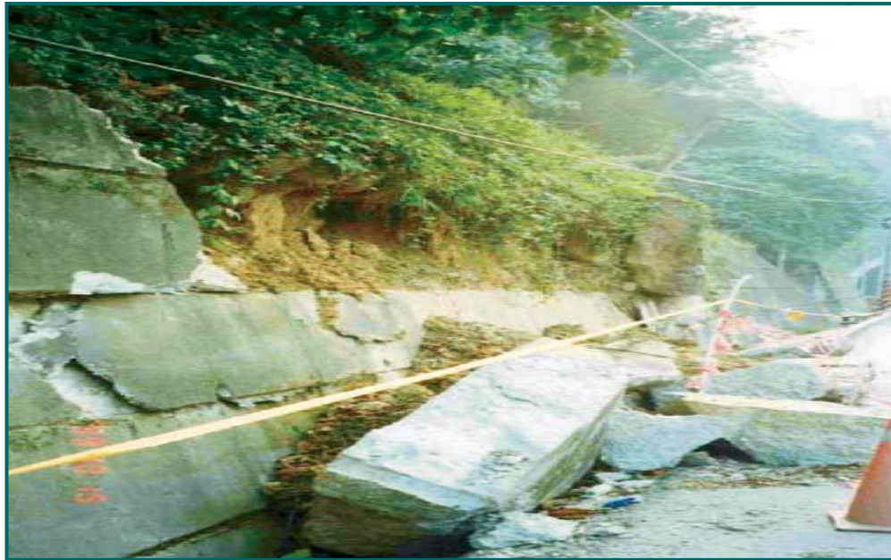
Figure 2 : Déplacement des couches supérieures du remblai le long des joints de construction en raison de la résistance de frottement insatisfaisante à la partie supérieure du mur (séisme de Chi-Chi Taiwan (1999)).
