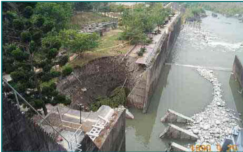
Figure 1 : Rupture par renversement d'un mur de soutènement, pendant le séisme de Chi-Chi Taiwan (1999).
