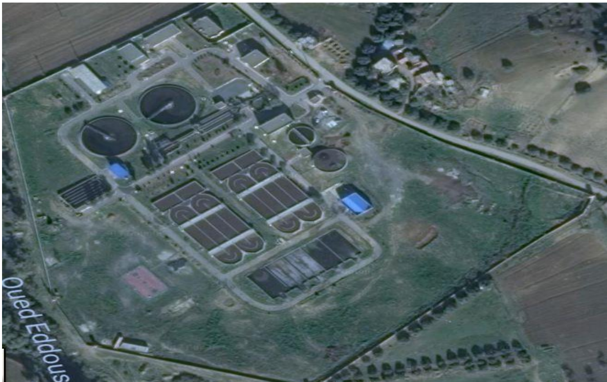
Figure 5 Situation géographique de la STEP de Bouira.
