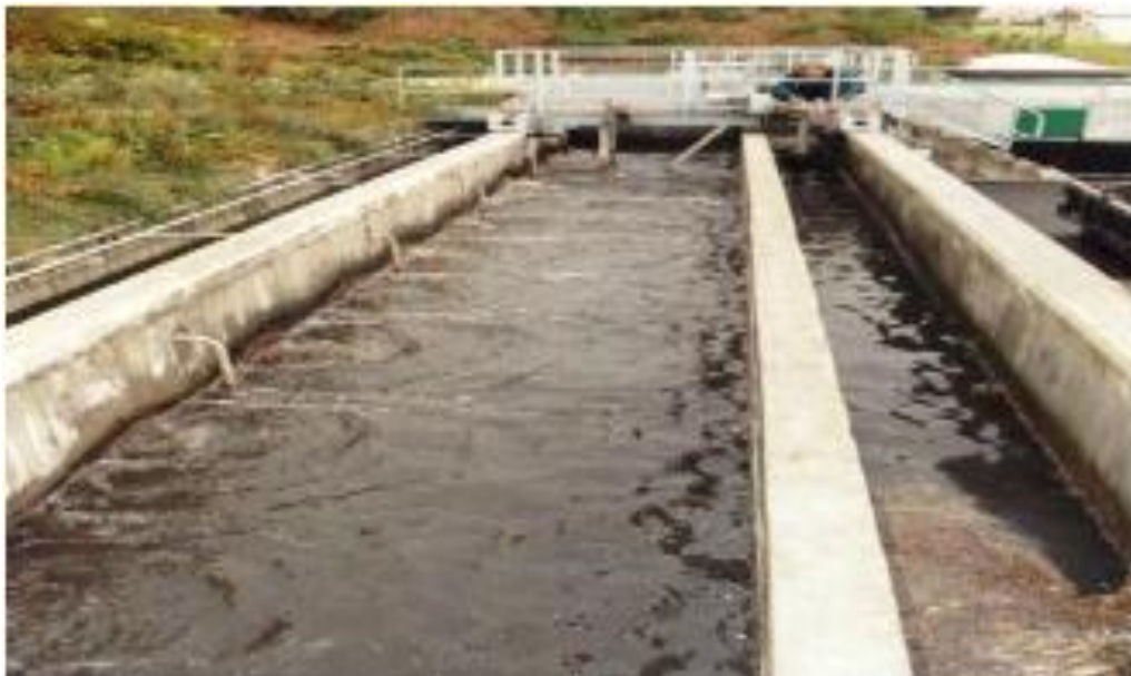
Figure 3: Photo d'un Dessabler de STEP de bouira (originale)
