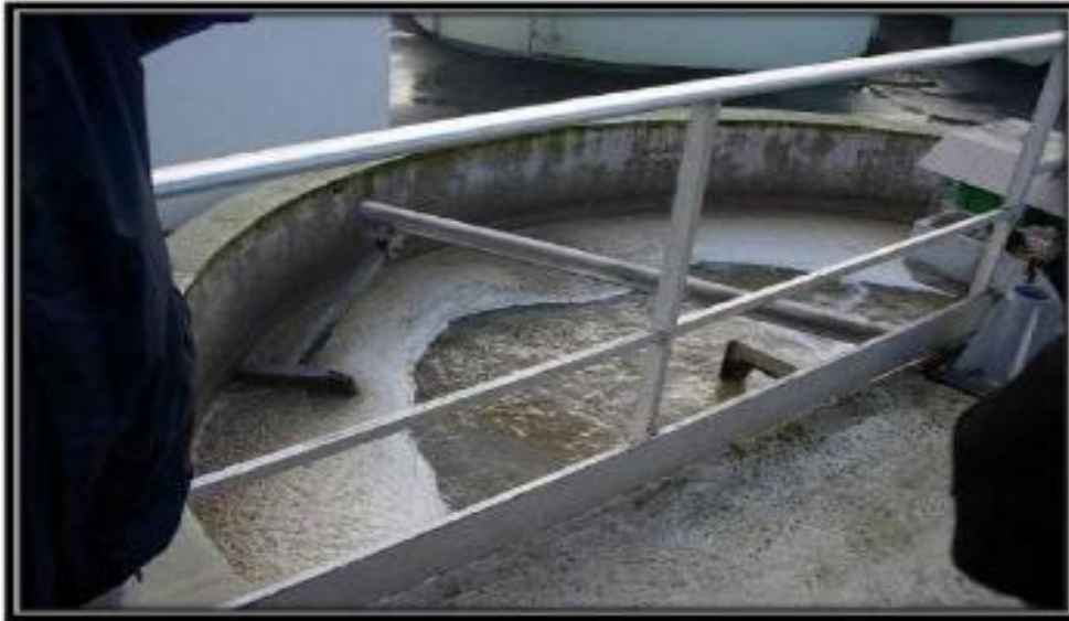
Figure 4: Photo d'un Déshuileur de STEP de Bouira (originale)
