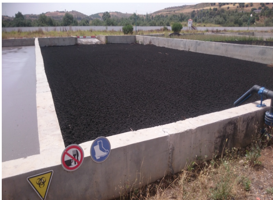
Figure 4. Lit de séchage des boues d'épuration dans la STEP de Bouira (ONA).
