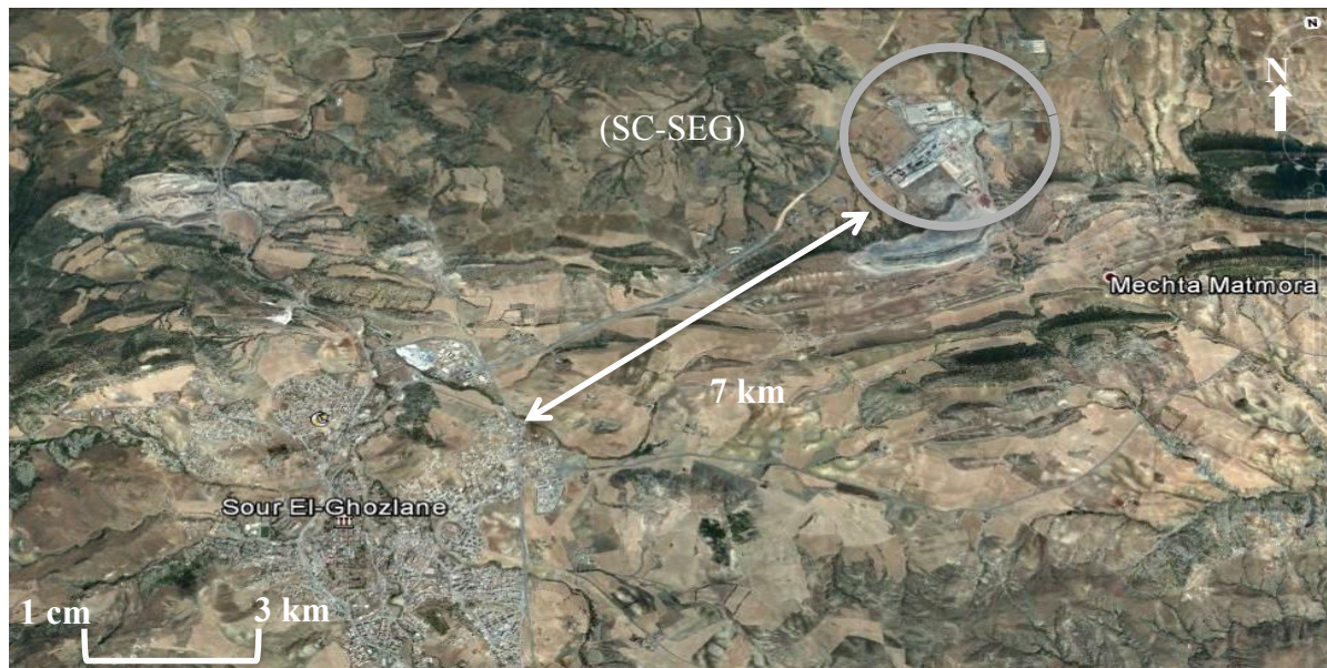
Figure 05 : Vue aérienne de la situation de la cimenterie (SC-SEG) (Source : Google Earth, 2017).
