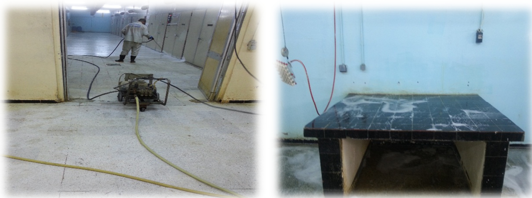
Photos 12: Le nettoyage et la désinfection au niveau de couvoir ( original )
