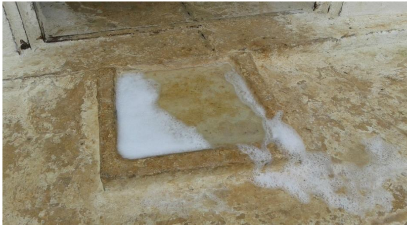
Figure 17 : Pédiluve du bâtiment(photo personnelle).
