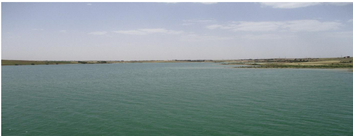
Photo N°12: Vue du barrage Lakhel (Ain Bessem).
