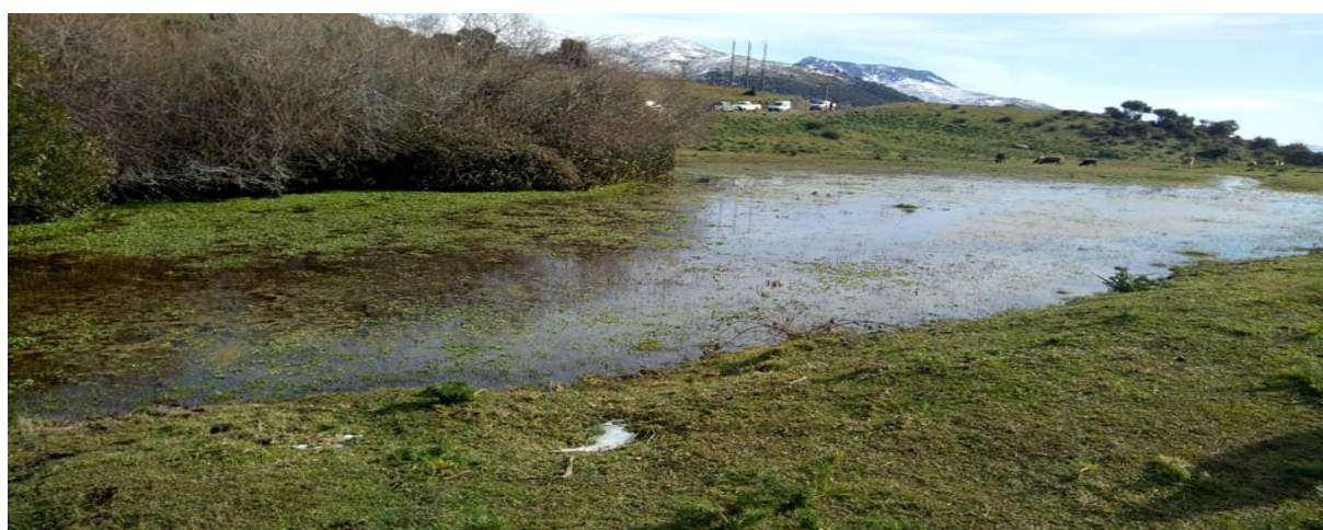
Photo N°19 : Vue générale de la retenue collinaire Chabet Mardja.
