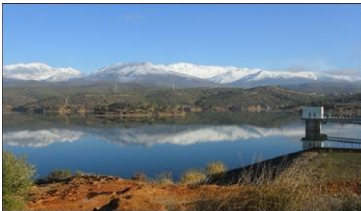
Photo N°11 : Vue générale du barrage Tilesdit.
