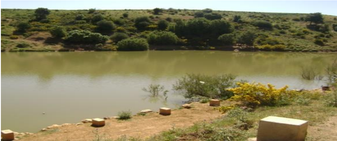
Photo N°17: Vue générale de la retenue d'Errich
