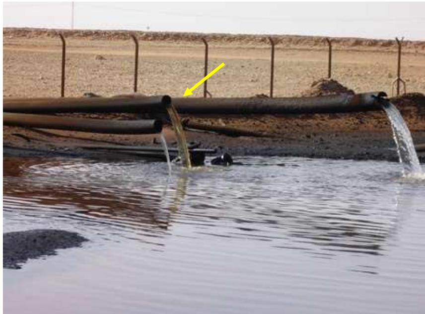
**Figure III.4:** Entrainement du pétrole brut sur la ligne de décantation MF5.
