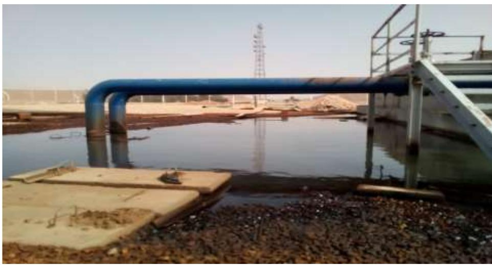
**Figure III.2:** Débordement du bassin de décantation à cause d'un mal entretien
