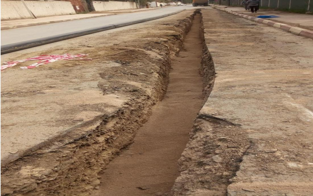
Figure(III.2) : pose de lit de sable
