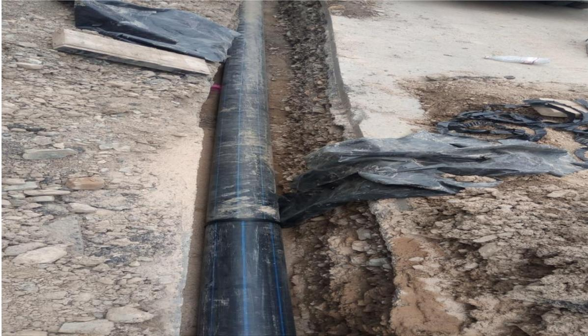
**Figure(III.3) : pose de conduite**
