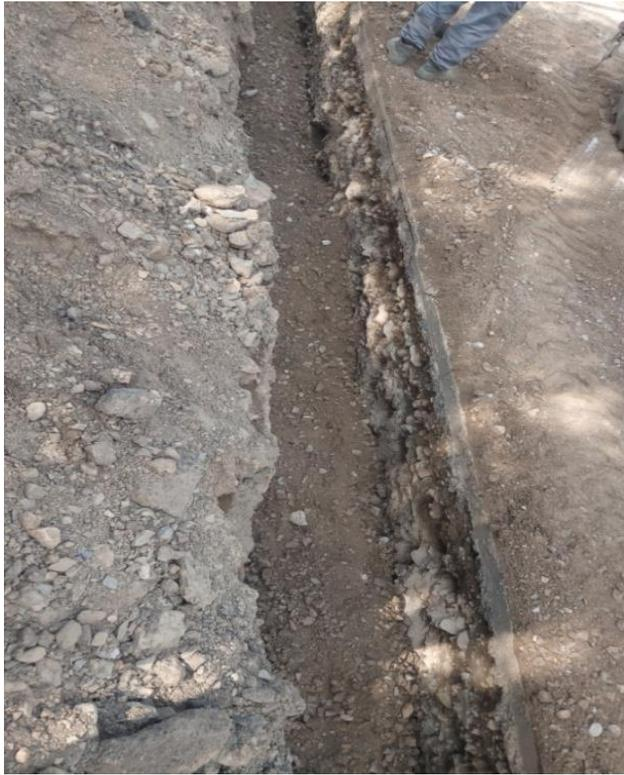
**Figure(III.4):** pose de remblai sur le conduite
