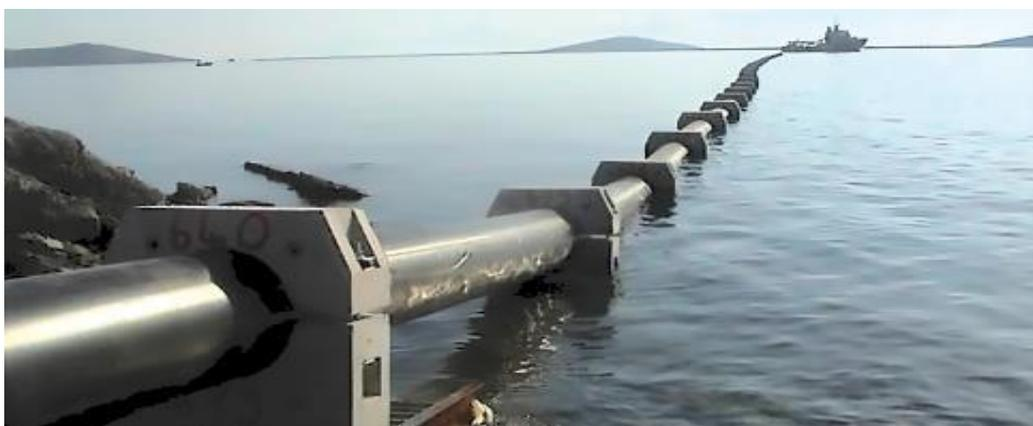
**Figure (II.4) :** Tubes PEHD dans le dessalement de l'eau de mer [3]
