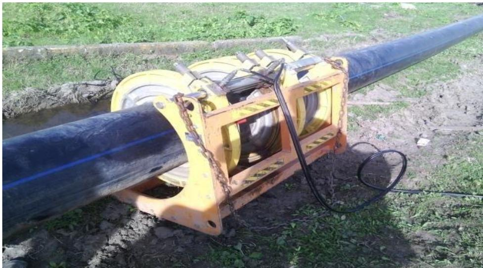
**Figure (II.8):** Machine à souder bout à bout
