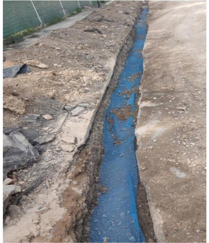
**Figure(III.5) :** pose de filet
