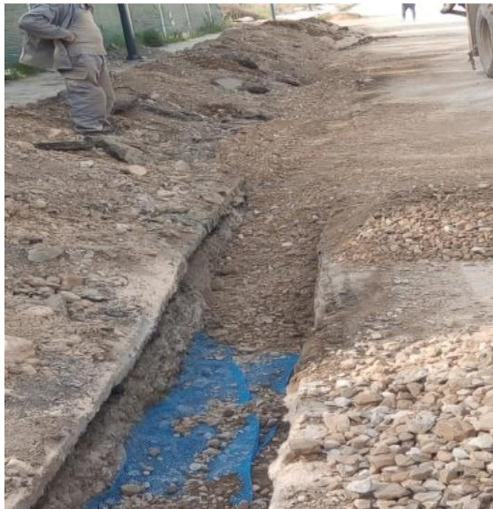
**Figure (III.6) :** pose de remblai sur le filet a niveau de route
