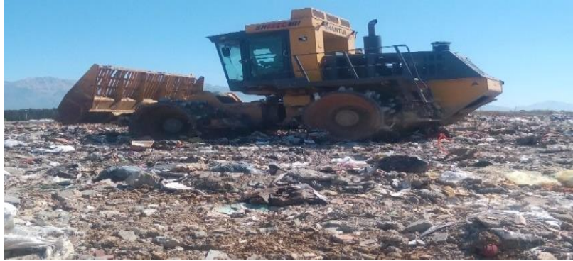
Figure 30: opération de compactage des déchets
