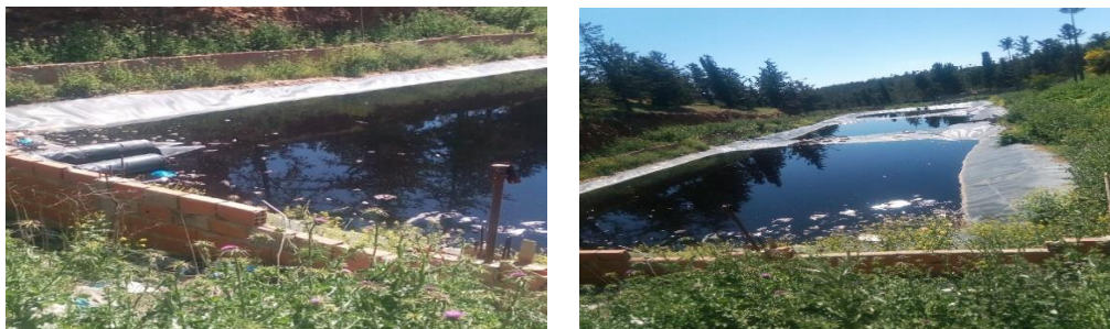
Figure 21 : les bassins de lagunage
