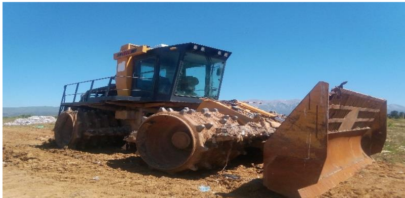
Figure 31 : opération de recouvrement des déchets
