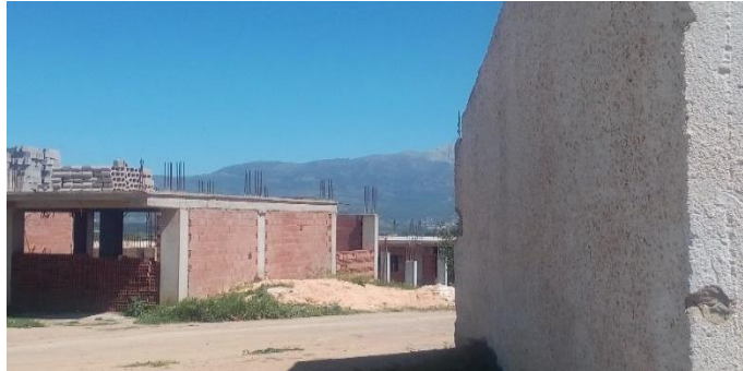
Figure 36 : l'habitation qui entore le CET
