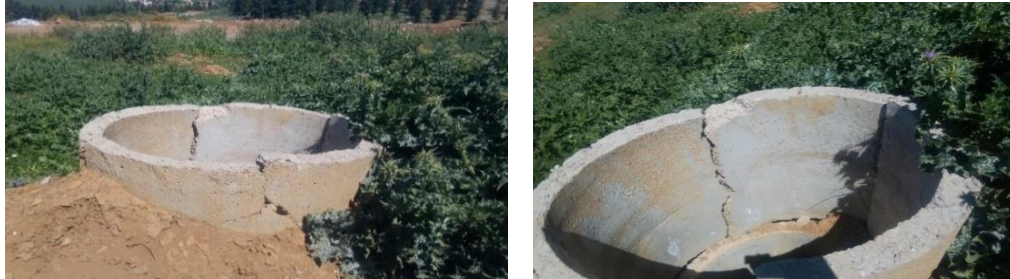
Figure 22 : les cheminées de récupération de biogaz
