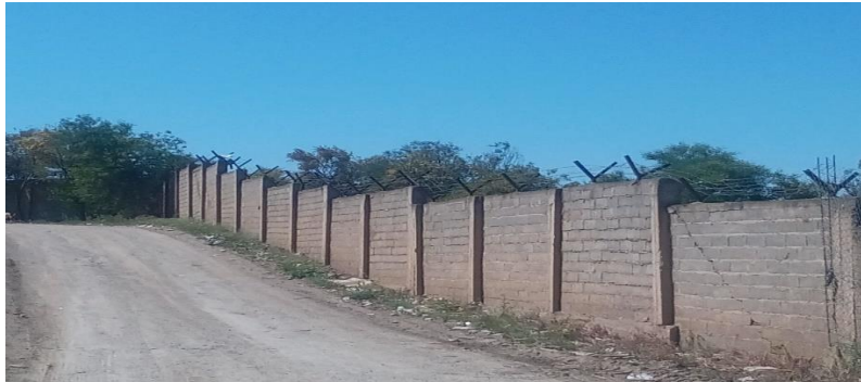
Figure 17 : le clôture de CET
