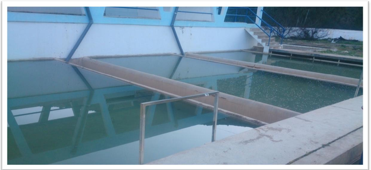
**Figure I.10:** Filtres à sable
