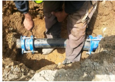
Figure 15:Manchons maxi (joint gibout) +une chute PEHD DN 90 mm
