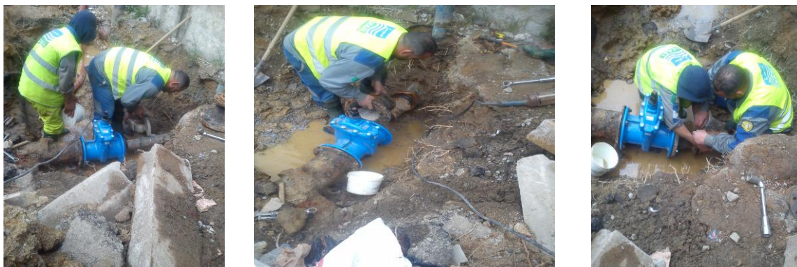
Figure 28: les travaux de by-pass
