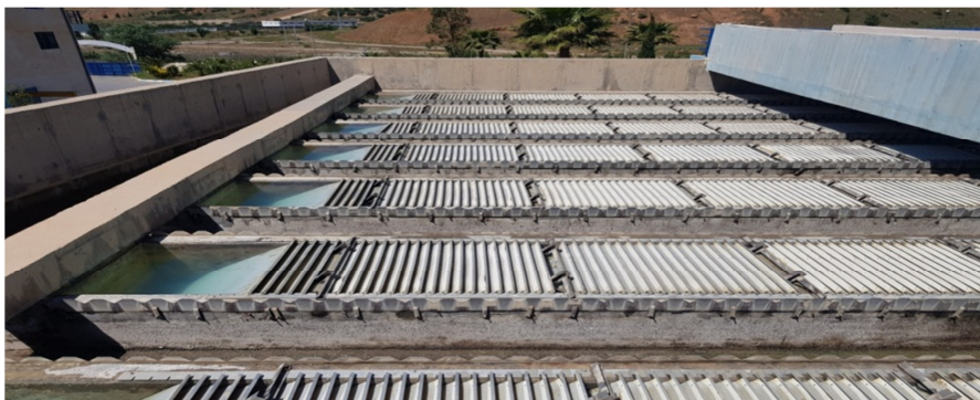
Figure 2.4 : Décanteurs lamellaires.
