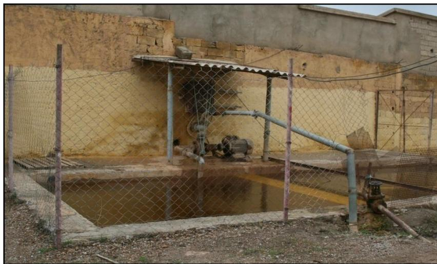
**Figure II.13:** Bassins de décantation et recyclage des eaux du système de protection de l'environnement
