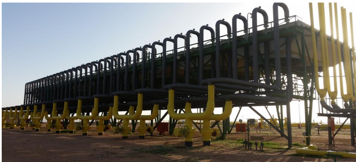
Figure II- 8 : Refroidisseurs Gaz Naturel 405/2001
