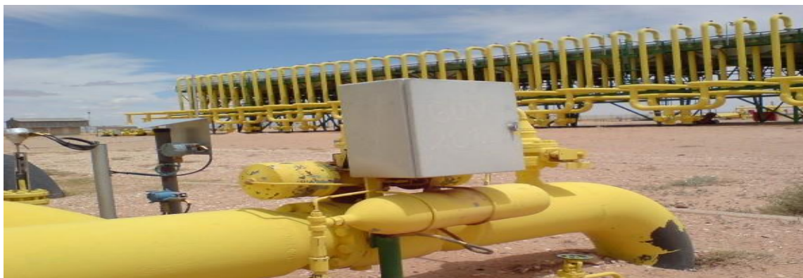
Figure III- 5 : Vanne d'Event Collecteur Refoulement GOV2014
