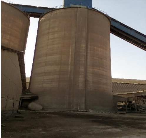
Figure 04 : Silos de stockage
