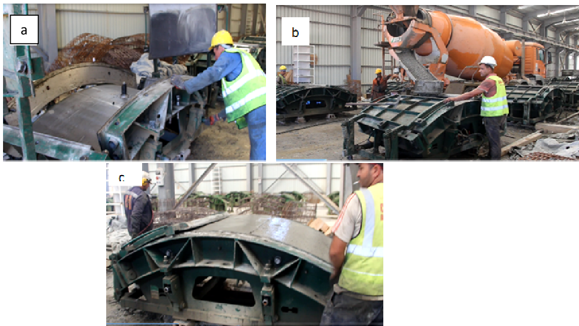
Figure 5. Fabrication des voussoirs
