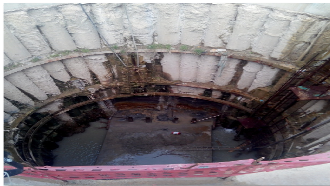
Figure 7. Vue d'un puits de sortie
