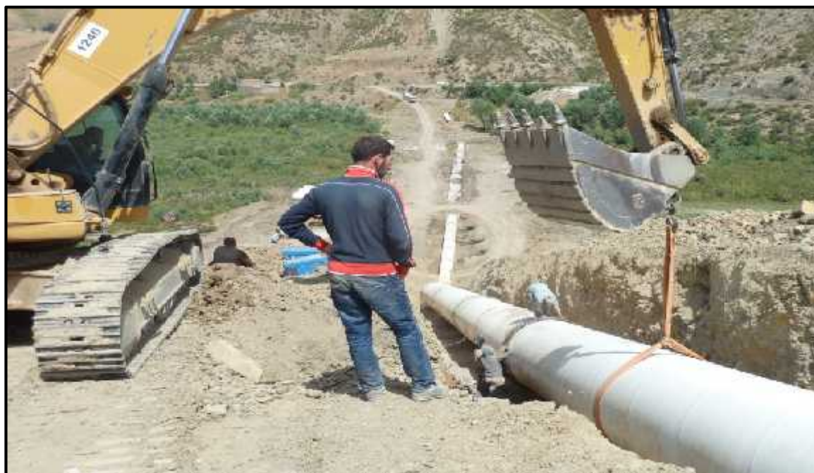
Figure 9 : Pose canalisation en Oued N'Seur (Drâa El Gaïd)
