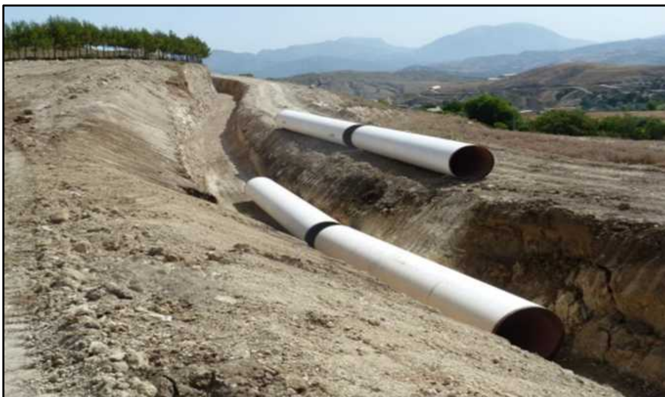
Figure 10 : Bardage des conduites hors la tranchée
