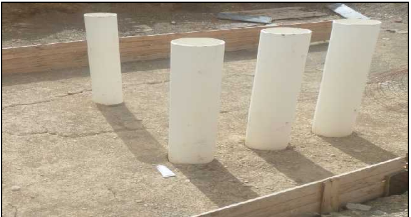
Figure 12 : Ventouse avec 3 tubes d'entrer d'air
