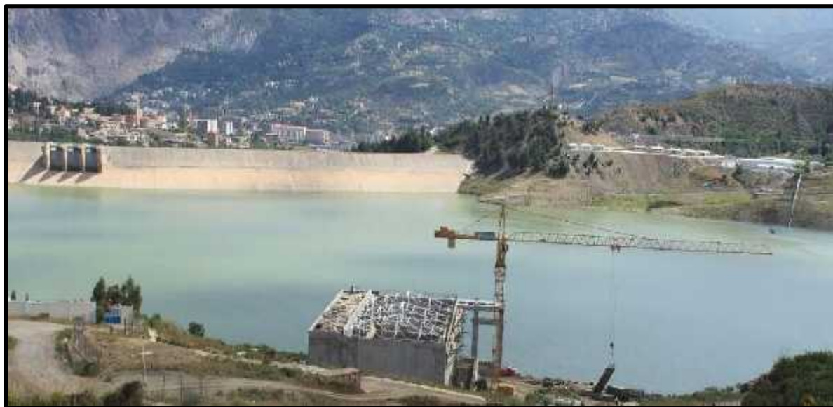
Figure 3 : la station de pompage (Kherrata)
