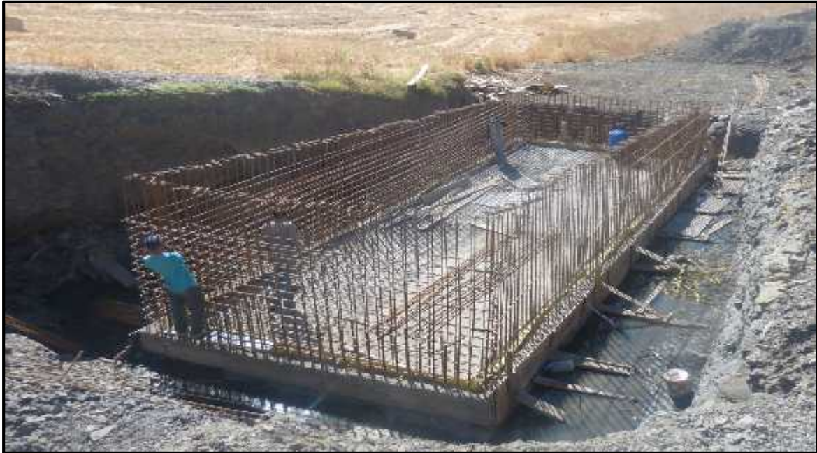
Figure 17 : La réalisation du bassin de dissipation
