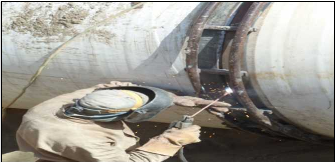
Figure 11 : La soudure des conduites
