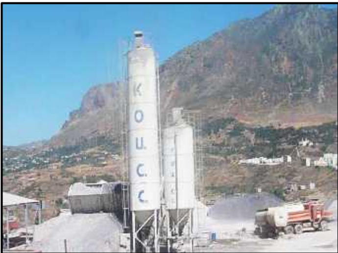
11-Central à béton
