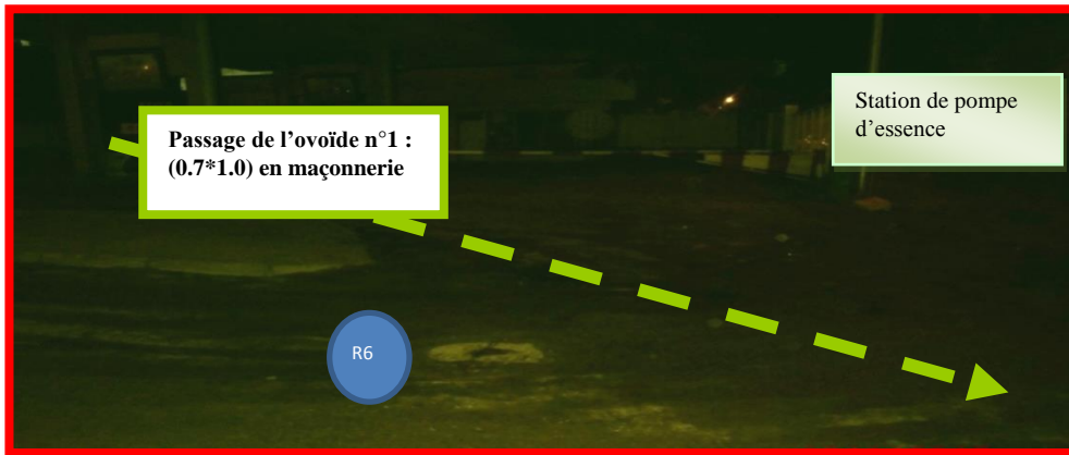
FigureN 03 passage de l'ovoïde (1.0*0.7) m au niveau de la station de pompe d'essence
