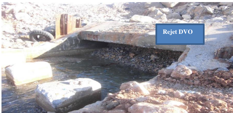
Figure N°9: Rejet de d »versoir d'orage au niveau du collecteur Alger sud
