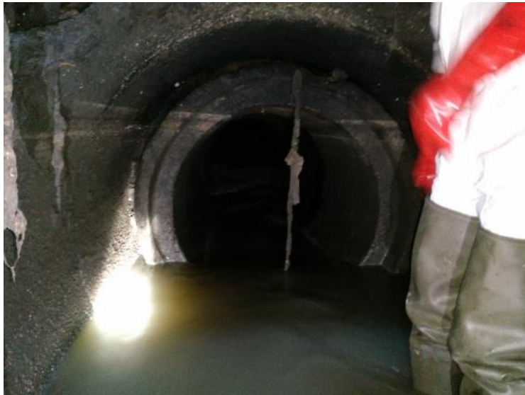
Figure N°7: Rétrécissement Ø 1350 - Ø 1000 au niveau du R13
