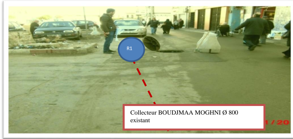
FigureN 0 1: point de départ du collecteur en béton armé Ø 800
