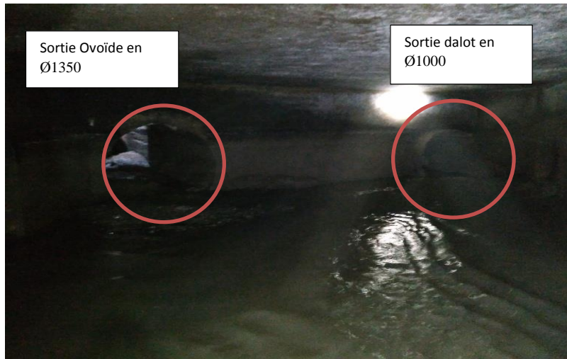
Figure N°8: Chambre finale (dalot et ovoïde)
