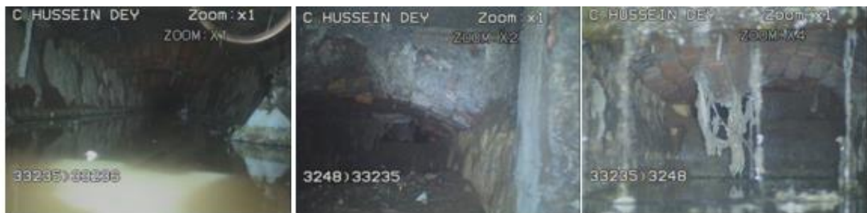
Figure N 0 10 : Regard de tête de l'ovoïde (0.7 x 01) m qui loge la rue Tripoli.
