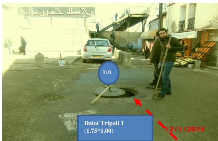
Figure N 05 : passage du dalot Tripoli 1
