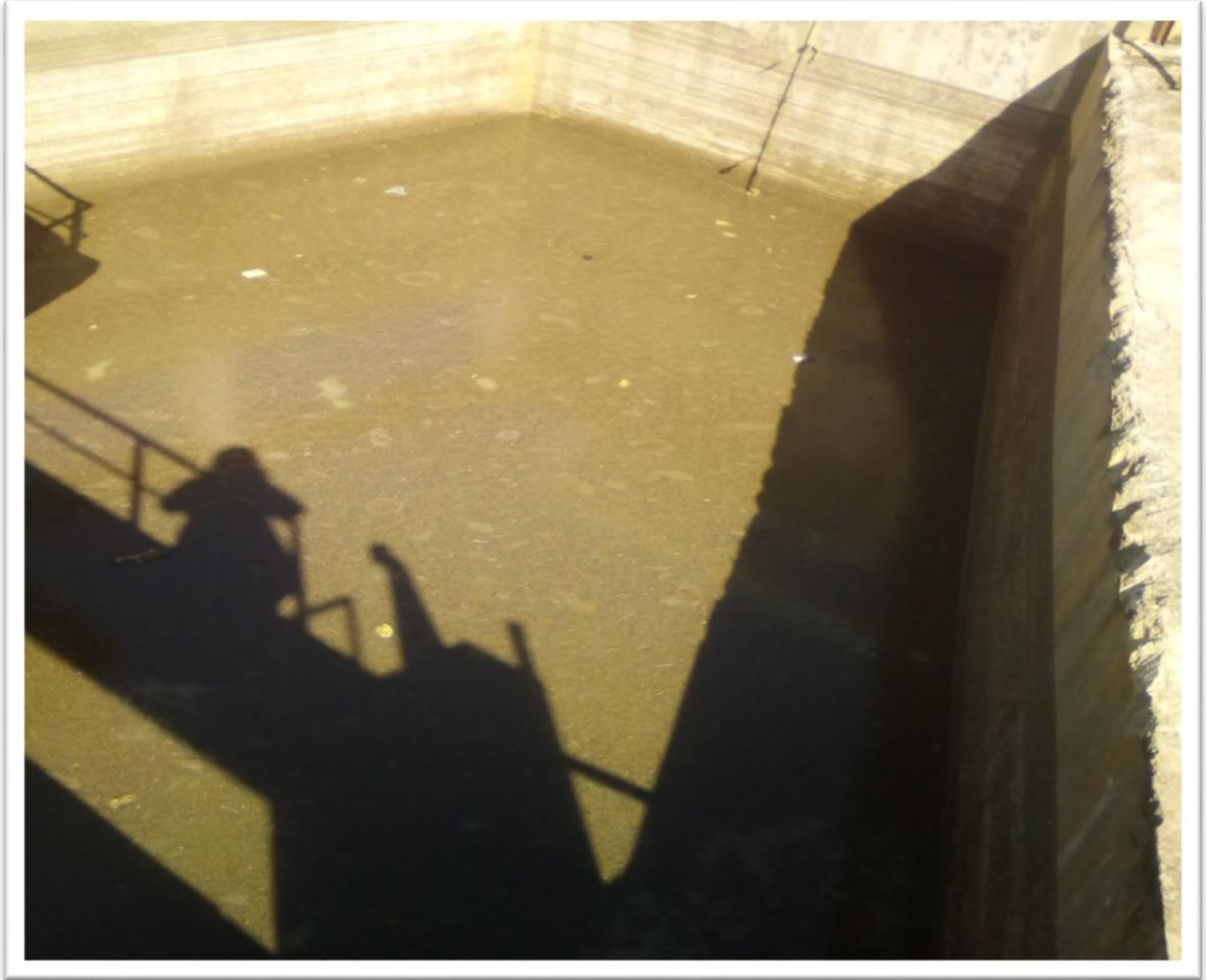
Figure 13 : Les débris solides et les matières fines dans la chambre de relevage après le dégrillage
