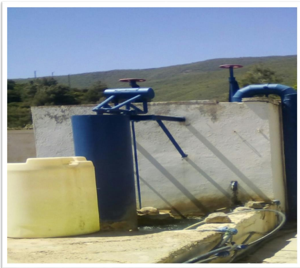
Figure 09: La chambre d'équilibre et la vanne cylindrique
