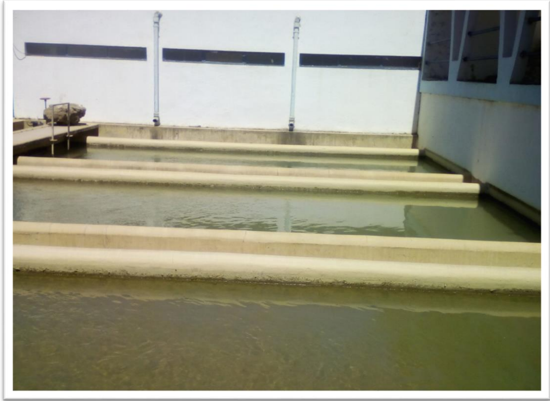
Figure 12: Les filtres à sable
