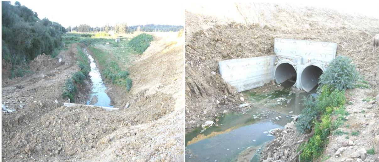
**Figure I-7 :** Passage buse amont et aval lieu du collecteur des eaux usées.
