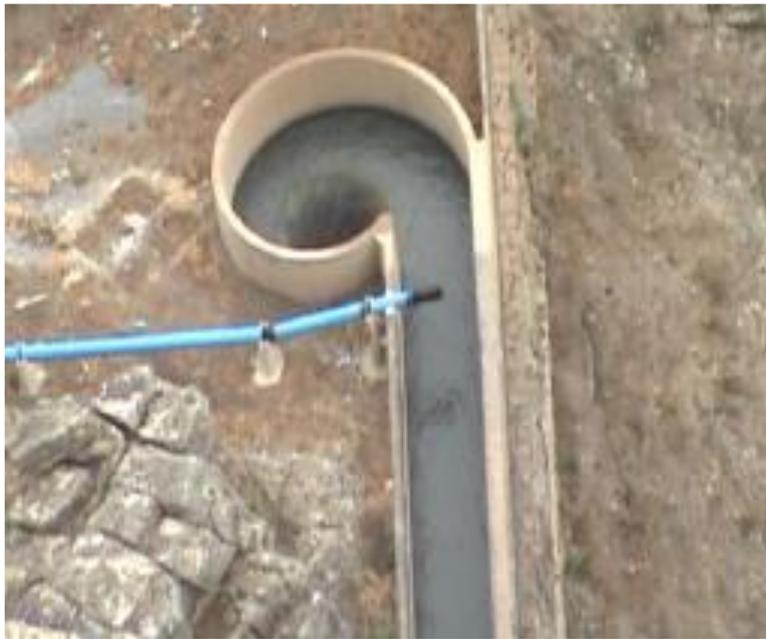
**Figure III-20 : Le puits Vortex**
