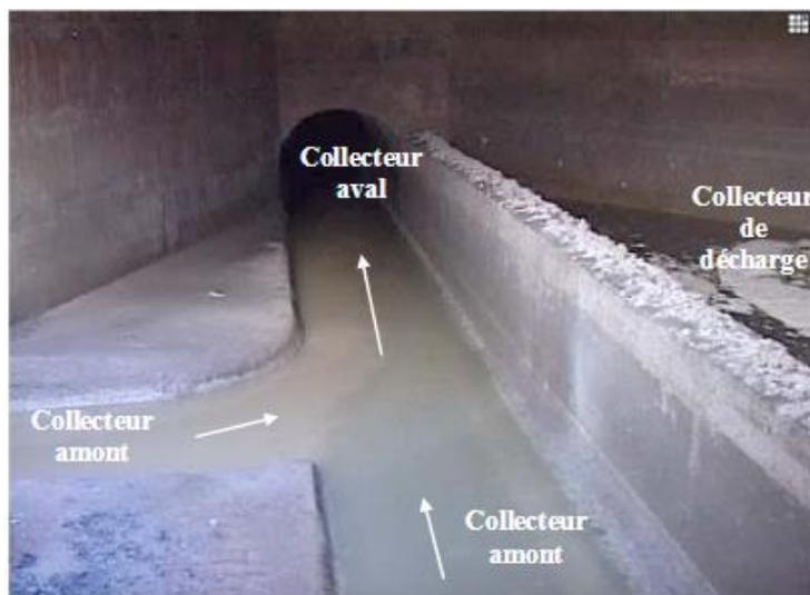
**Figure II-15 : Déversoir d'orage d'un seuil latéral**
