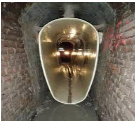
**Figure II-12 : Conduite ovoïde en PRV**
