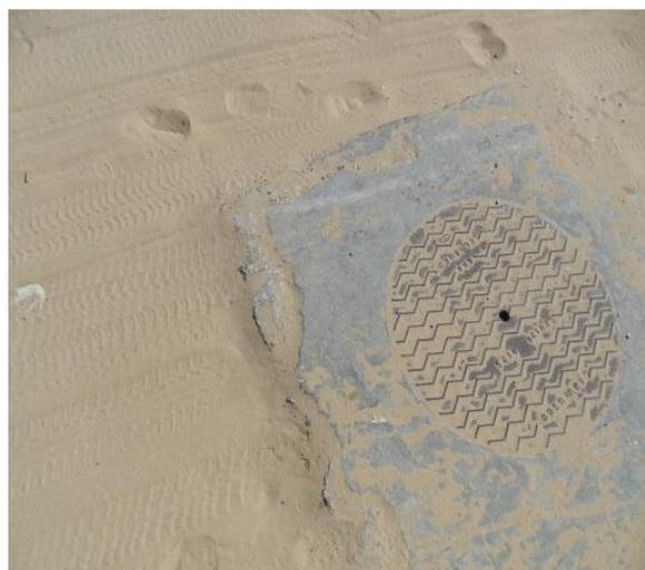
**Figure VI-6 : Désagrégation en béton**
