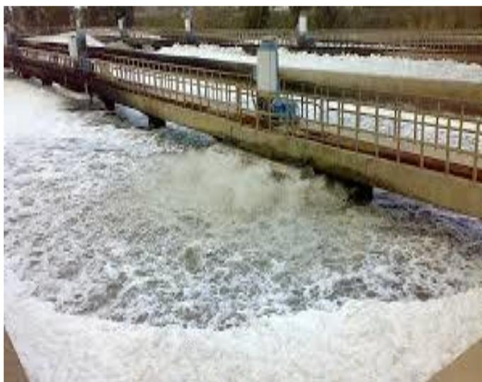
**Figure IV-4 : Bassin d'aération de boue**
