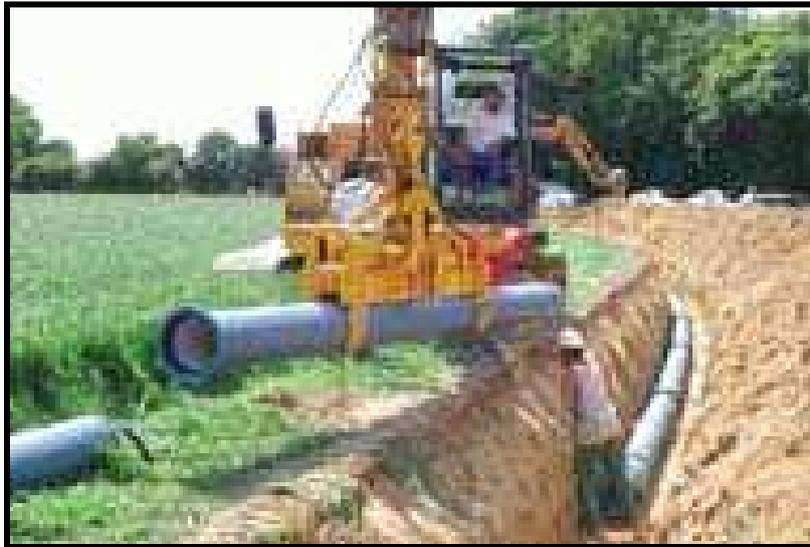
**Fig.08** : Pose de conduite dans un terrain ordinaire.
