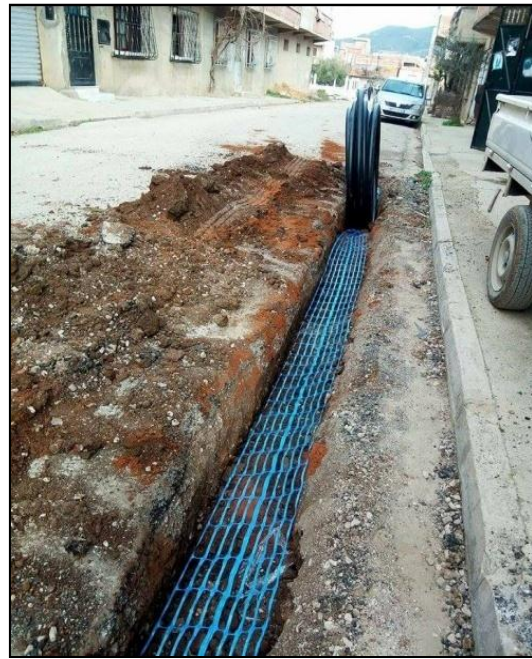
Figure V.4.Pose du grillage avertisseur
