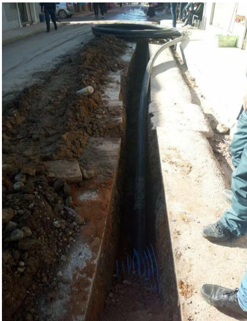
Figure V.3.Pose de la conduite
