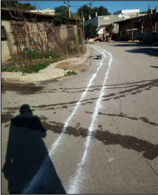
Figure V.1.Tracé du réseau
