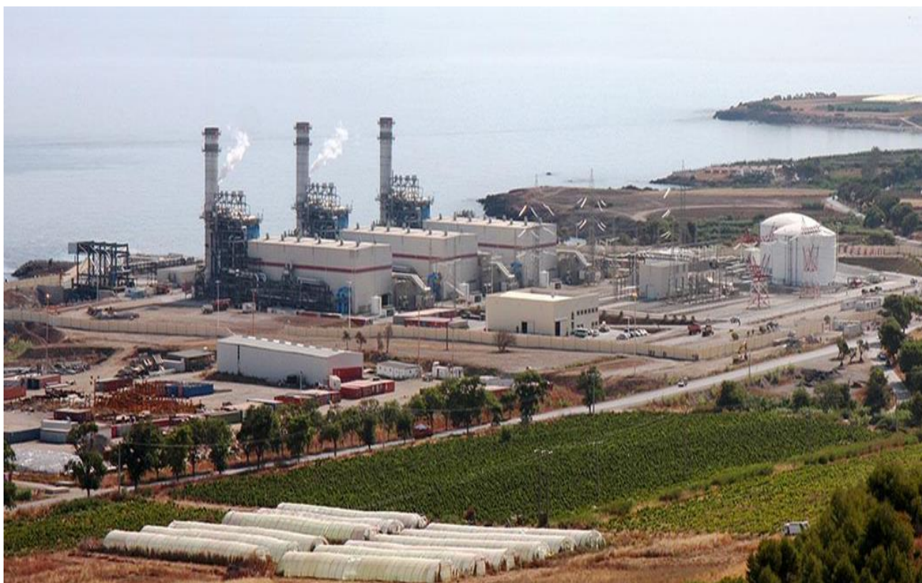
Figure I.1. Vue aérienne de la station Hadjret En Nous
