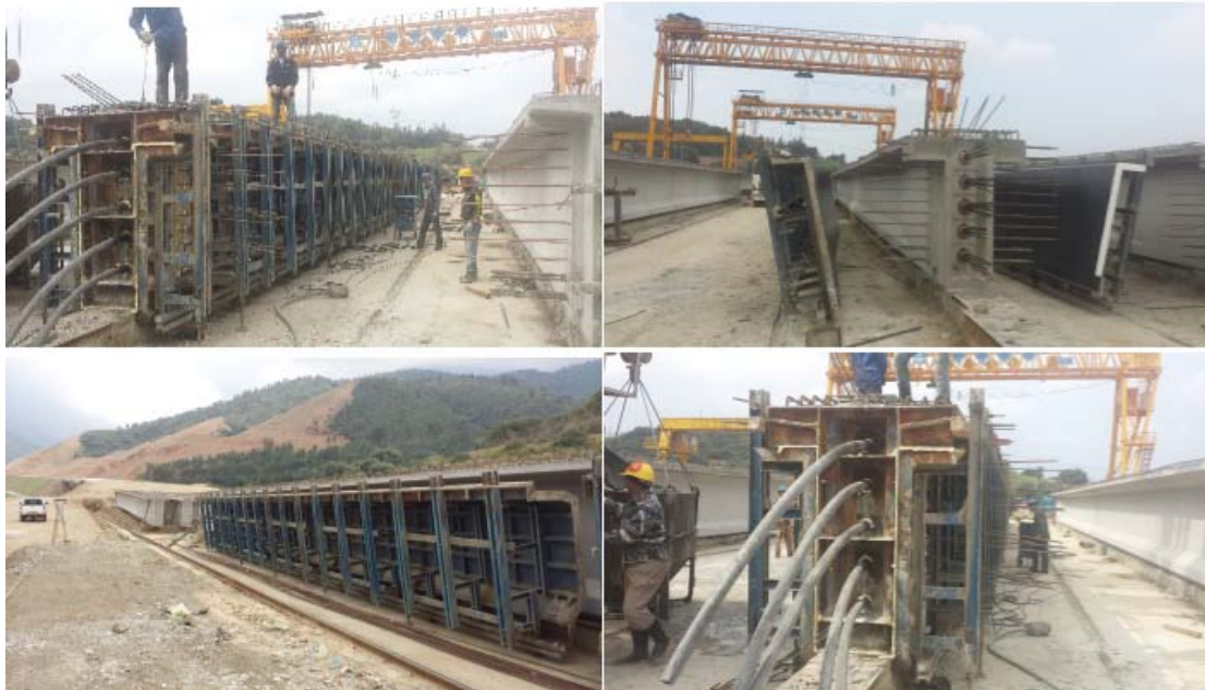
Figure 1-2-1-4 : coffrage des poutres
