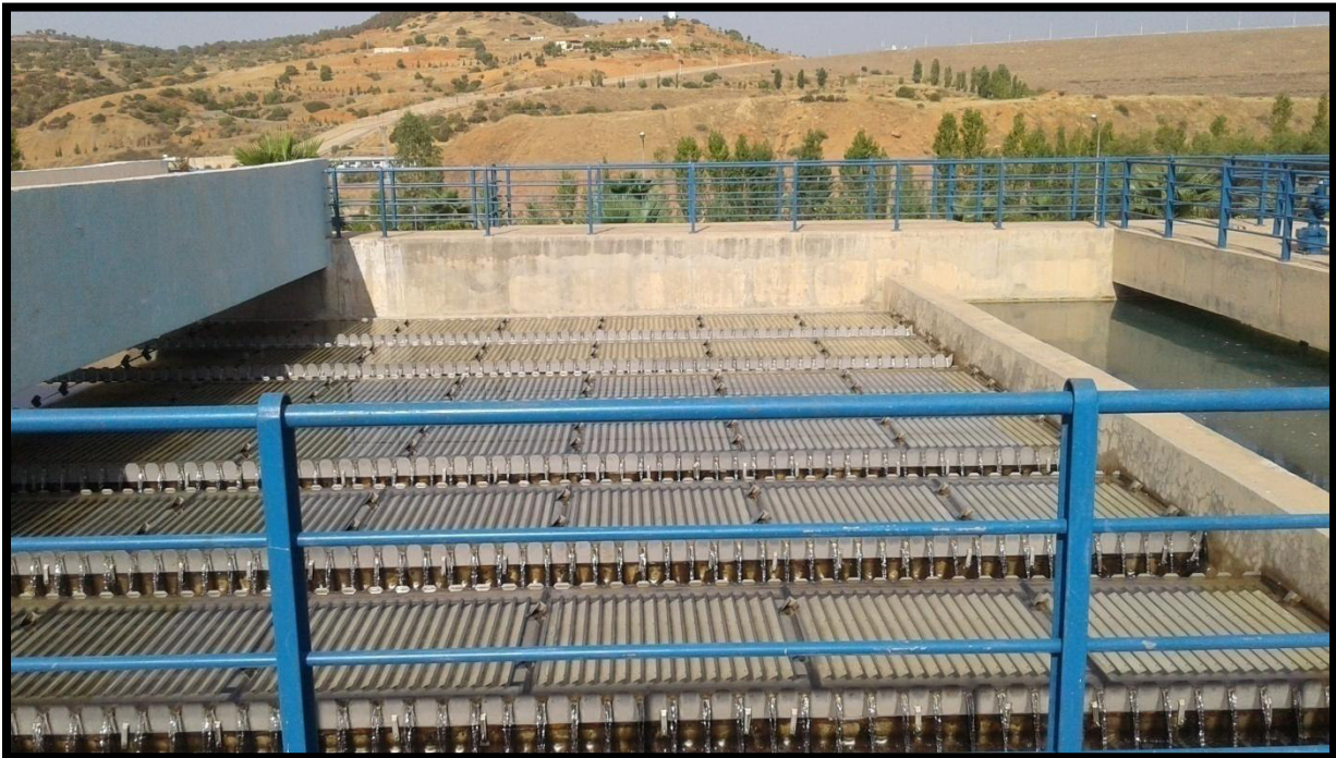
Figure III.2 : Décantateur lamellaire
