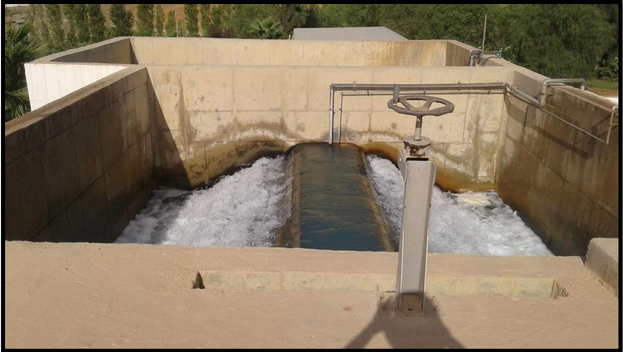
Figure III.1 : Cascade d'aération
