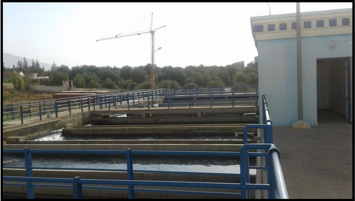
Figure III.3 : Filtre à sable
