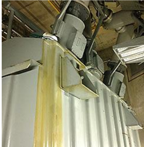
Figure (I.13) : Déformation de Fuite d'huile. [8]
