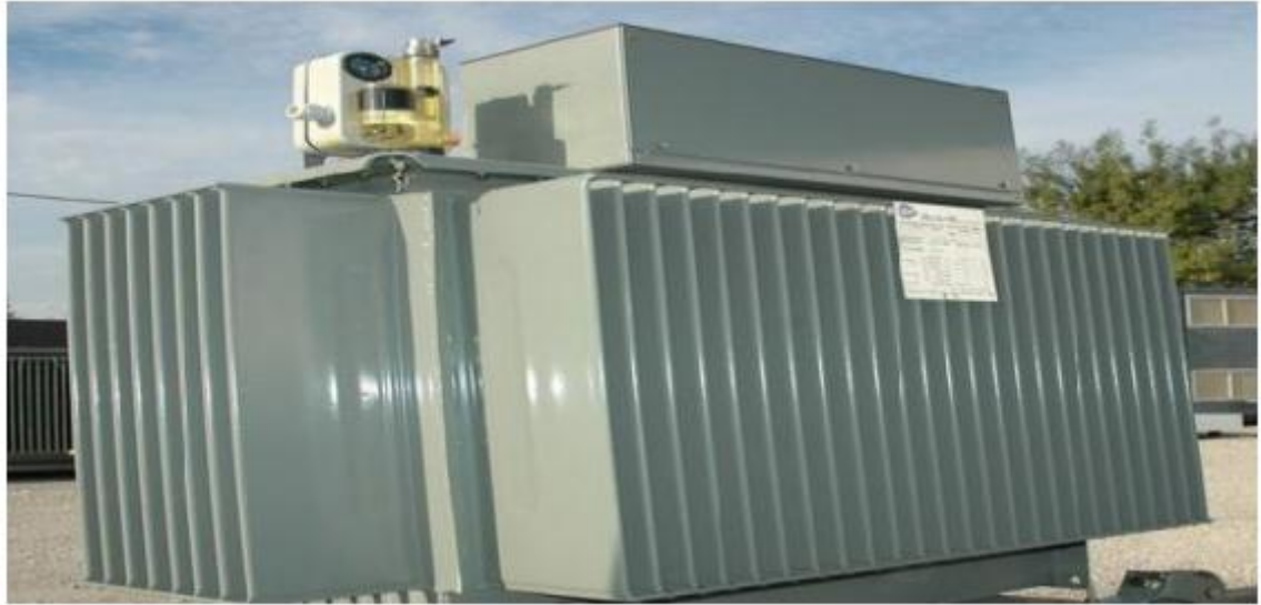
Figure (I.8) : La cuve d'un transformateur de puissance.
