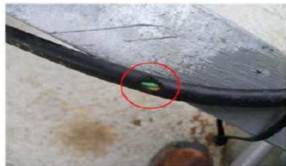
Figure (II.9) : Exemples de défauts rencontrés dans le système de câblage [26].
