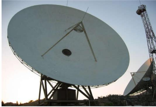
**Figure 3.1** l'antenne Cassegrain de la station CTS (Antenne de diamètre 32 mètre, type : Cassegrain, fréquence d'exploitation : bande C).
