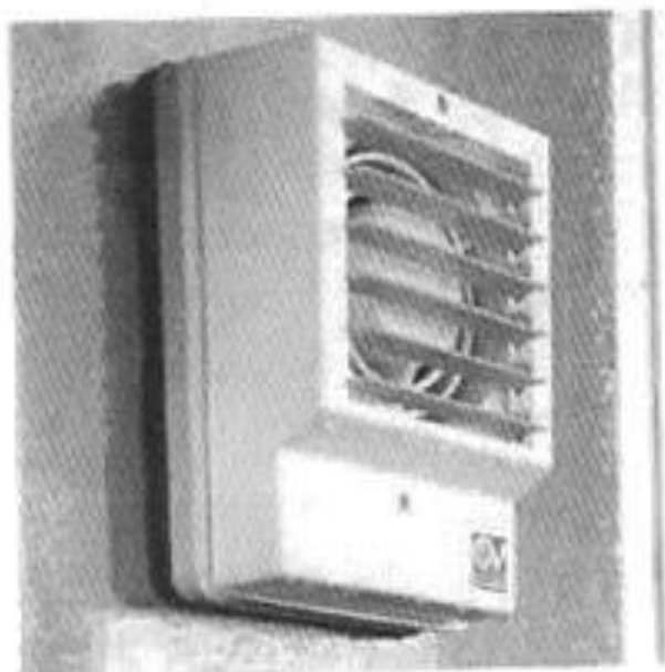
Figure (2.16) : aérateur hélicoïde pour montage sur une parois.
