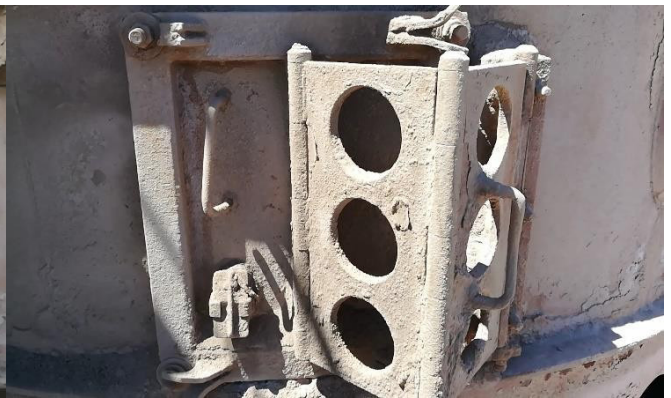
Figure 6. 5 Porte visite d'un cyclone de la tour de préchauffage
