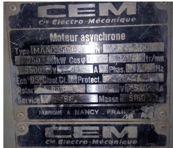
Figure 2. 2 Plaque signalétique du ventilateur « atelier broyage cru »
