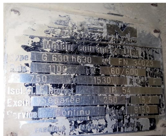
Figure 2. 4 Plaque signalétique du ventilateur « atelier four »
