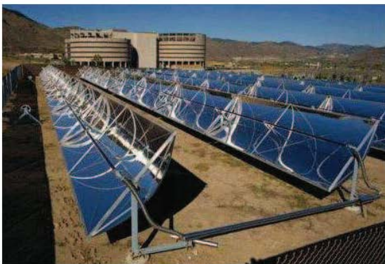
Figure (I.21): Photographies de deux installations utilisant des capteurs cylindro-paraboliques [10, 11]
