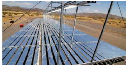
Figure (I.23) : Photographies de deux installations utilisant des capteurs à lentille de Fresnel [11]
