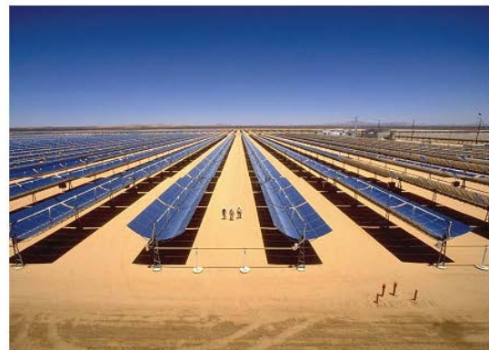
Figure (I.21): Photographies de deux installations utilisant des capteurs cylindro-paraboliques [10, 11]
