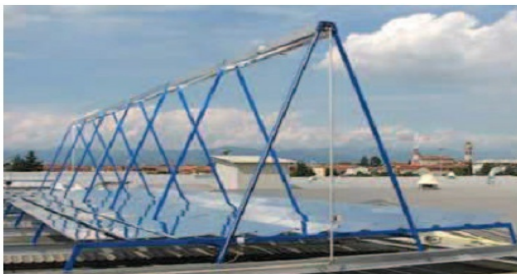
Figure (I.23) : Photographies de deux installations utilisant des capteurs à lentille de Fresnel [11]
