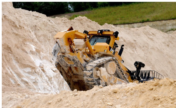
Figure I. 3 : Extraction de gypse à ciel ouvert
