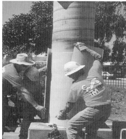
Figure I.26: Confinement des poteaux par coquille PRF préfabriquée.
