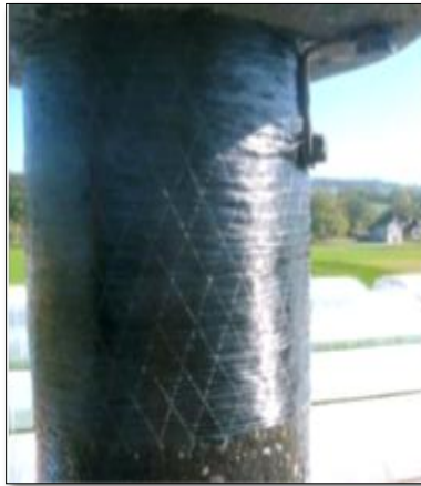
Figure I.20: Poteau circulaire en béton armé confiné par matériaux composites. [32]
