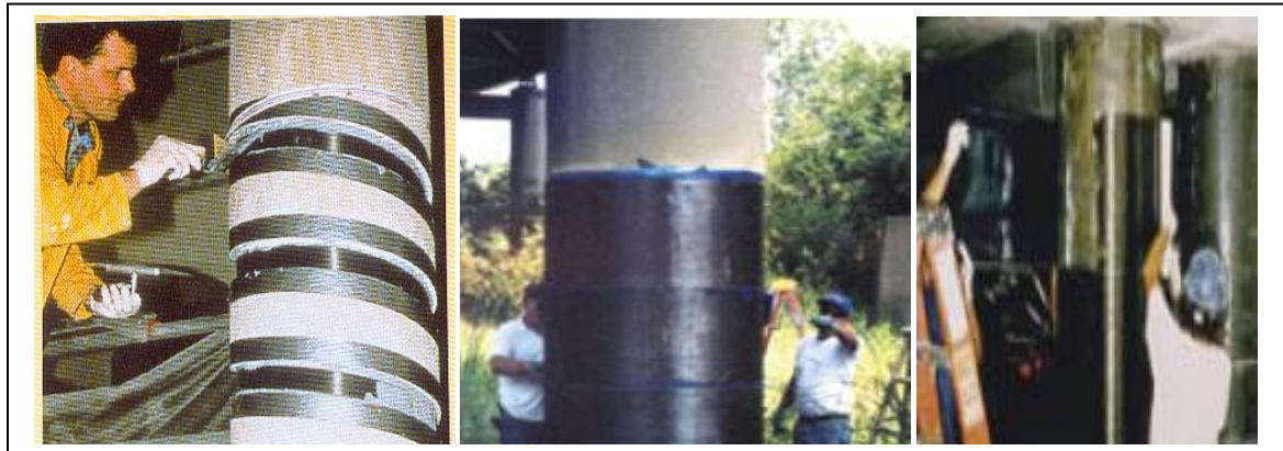
Figure I.24: Confinement des poteaux par stratification directe. [33]
