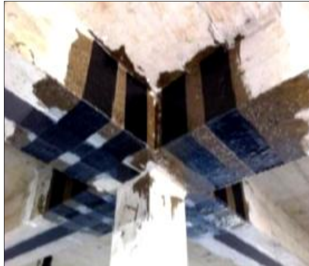
Figure I.21: Poutres en béton armé renforcées par FRP composites. [32]
