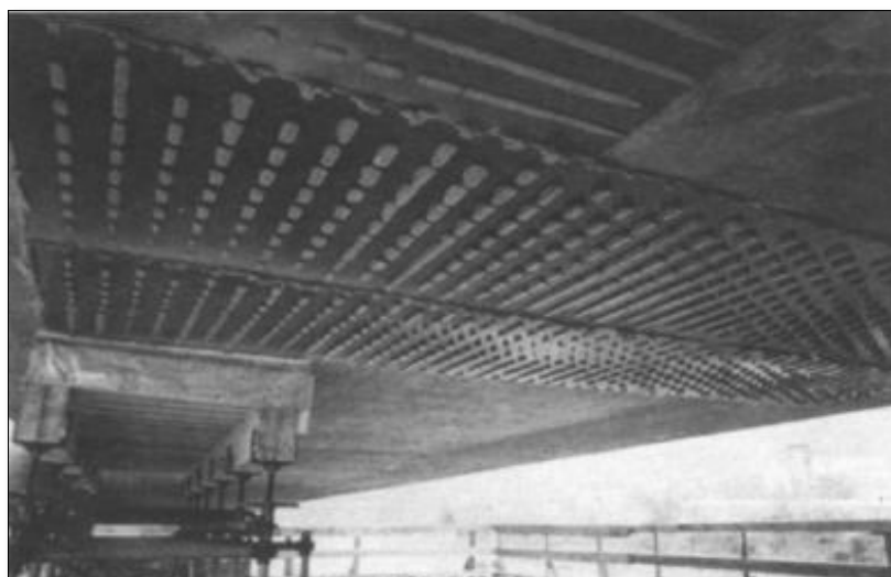
Figure I.12: Renforcement du viaduc de Terrenoire par tôles collées perforées -Brevet Freyssinet- (Luyckx 1999).
