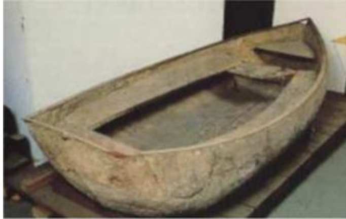
Figure II.1 : La première réalisation en béton armé : Joseph, Barque de Joseph Louis Lambot 1849, Musée de Brignoles.
