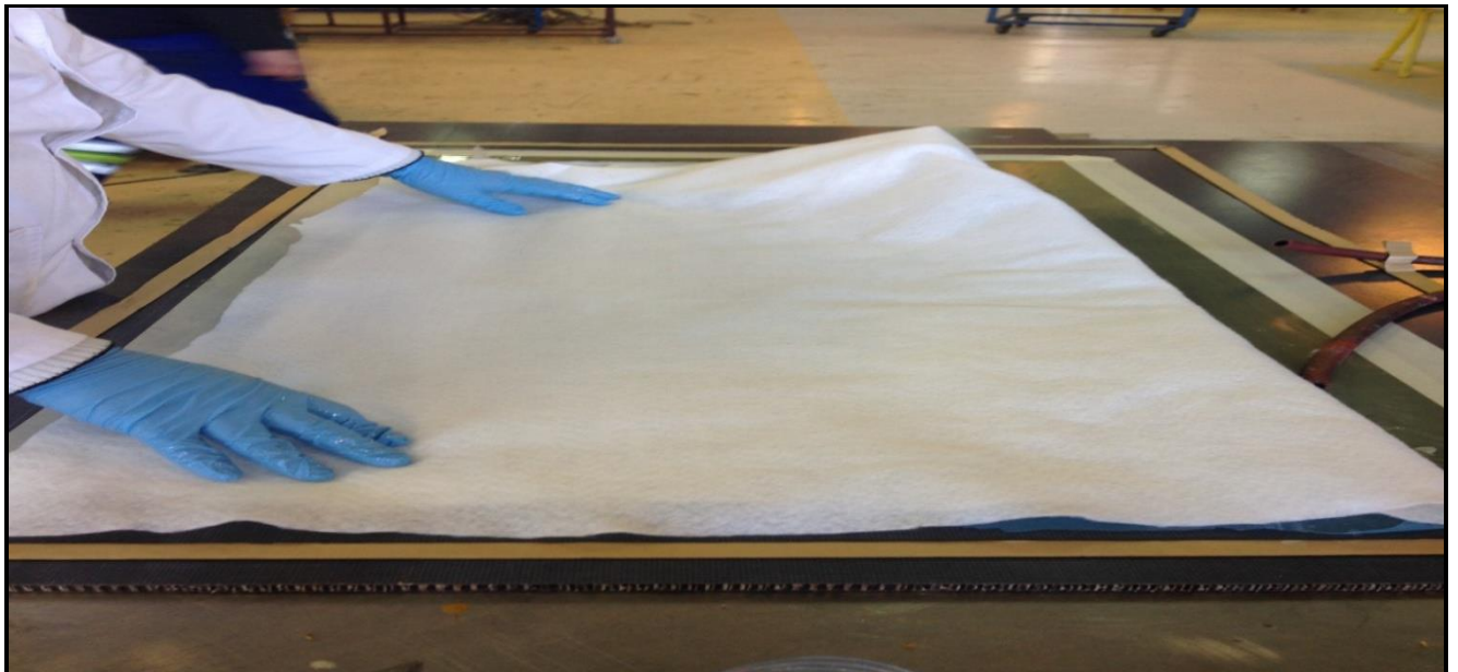
Figure 65. Dépôt du feutre de drainage
