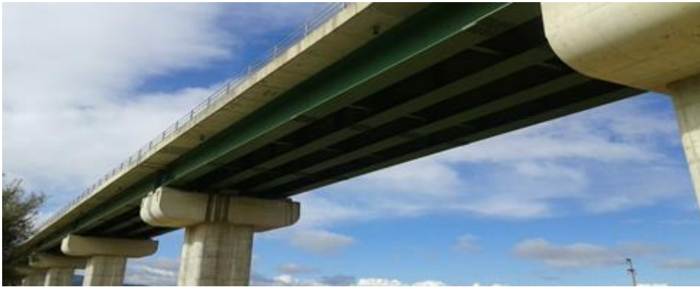
Figure 2.7 Exemple d'un pont mixte quadri poutre
