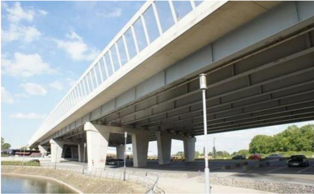
Figure2.2 Pont routier métallique
