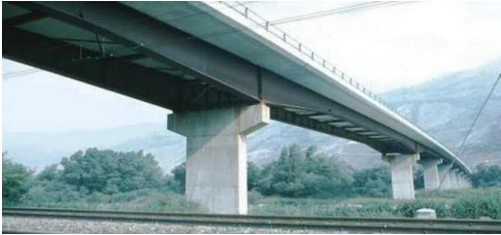
Figure 2.6 Exemple d'un pont mixte bipoutre
