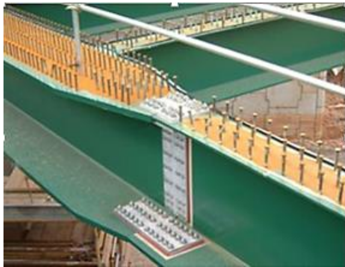
Figure 11.3 Connecteurs de type goujons
