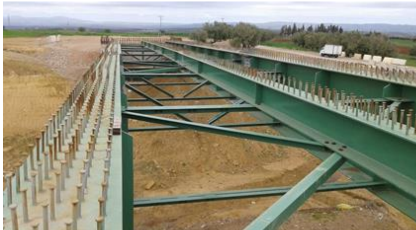
Figure 2.13 Connecteurs de type goujons
