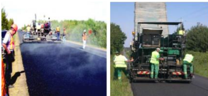
Figure III. 18: Technique de l'asphalt caoutchouté.
