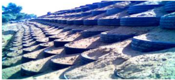
Figure III. 14: Pose des nappes de pneus Projet pilote – Route de Bousmail.
