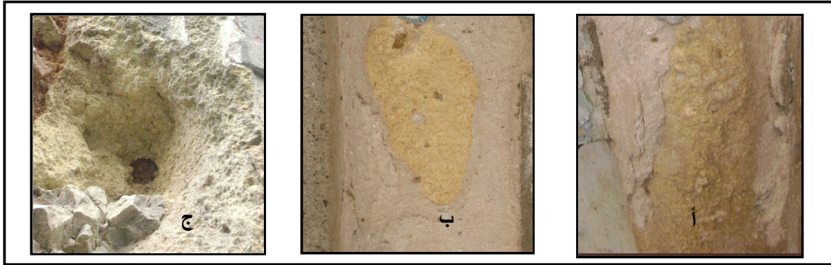
صورة رقم 54 ( أ ، ب ، ج ) : تفتت وتآكل حجارة الطوف بفعل الأملاح والرطوبة ، من تصوير الطالبة .
