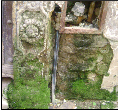
صورة رقم 06 : أثر الطحالب ودورها في ترسب الغبار وتآكل الحجارة ، من تصوير الطالبة .
