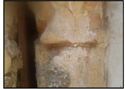
صورة رقم 12 ( أ ) : مظهر لتشقق حجارة الطوف ، من تصوير الطالبة .
