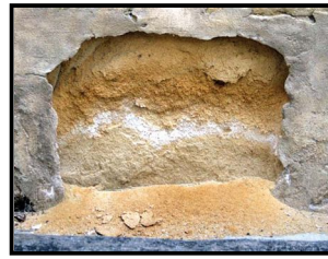
صورة رقم 14 (ب) : تفتت حجر رمل ، عن ، ICOMOS , Op Cit , P 45 .
