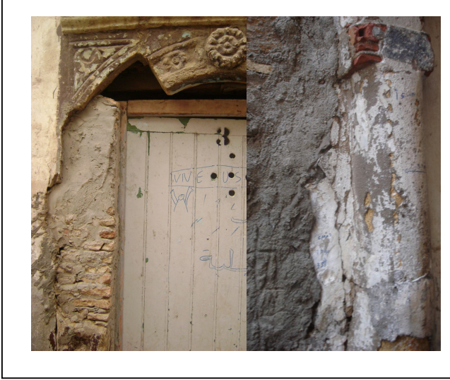
صورة رقم 44 : استعمال الإسمنت في التصليح ، من تصوير الطالبة .
