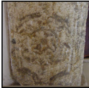
صورة رقم 16 (ب) : أثر التلوث على حجارة الطوف ، من تصوير الطالبة .
