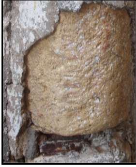
صورة رقم 12 ( ج ) : انفصال ناتج عن قطعة الحديد الصدئة ، من تصوير الطالبة .
