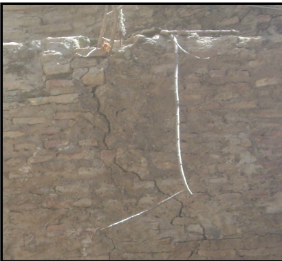
صورة رقم 48 : مظهر تشقق عمودي في الجدار ، من تصوير الطالبة .
