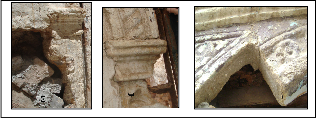
صورة رقم 49 ( أ، ب، ج ) : تمثل فقدان أجزاء مختلفة من حجارة الطوف ، من تصوير الطالبة .
