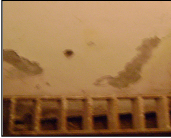
صورة رقم 38 : صعود المياه بالخاصة الشعرية وتأثيره على الجدار ، من تصوير الطالبة .
