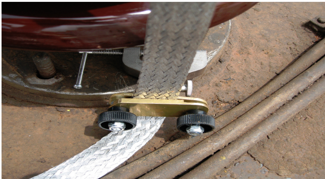
Figure III.10: Serrage de la pince à visser.
