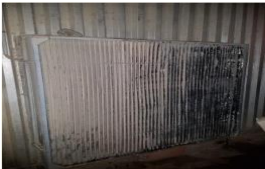
Figure 13 : Vue d'intérieure d'extracteur du bâtiment (Messili N, 2018).
