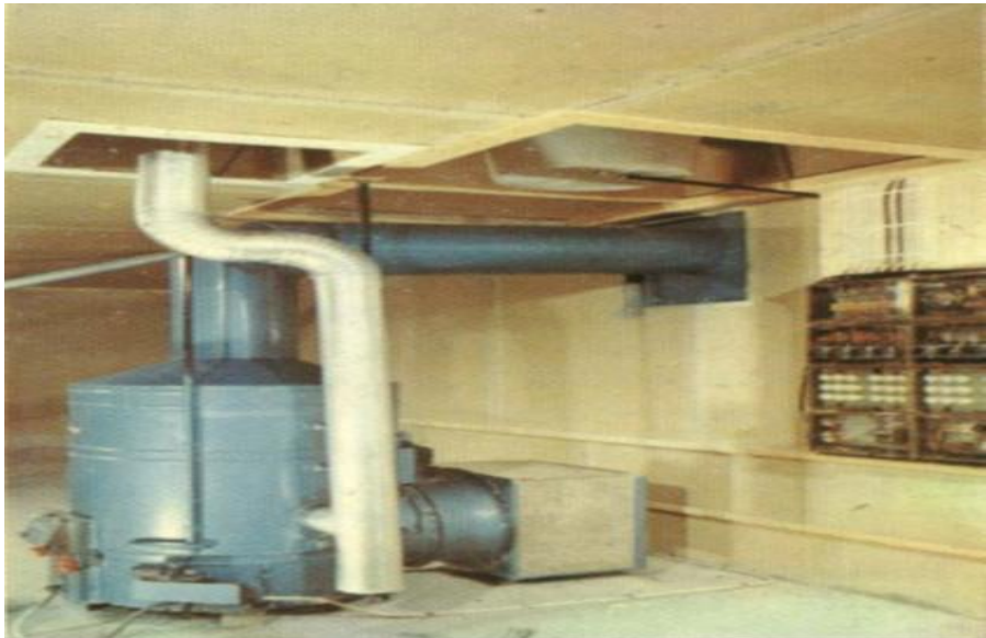
Figure 3: Chauffage à air pulsé (Saiki et Nacef ; 2019).
