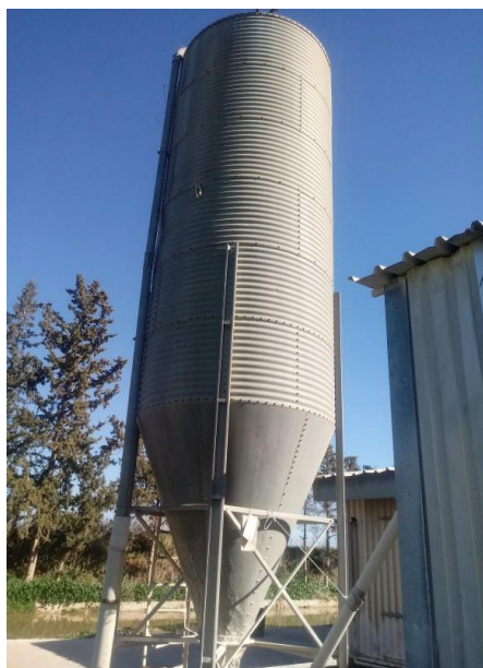
Figure 11: silos de stockage d'aliments(Photo personnelle, 2020).
