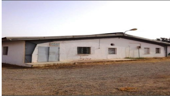
Figure 17: bâtiment d'élevage canicule (Meskouri, 2017)
