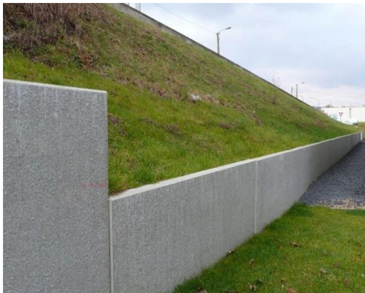
Figure I.2 : Murs en béton ou en maçonnerie.
