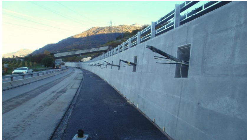
Figure I.6: les murs ancrés.
