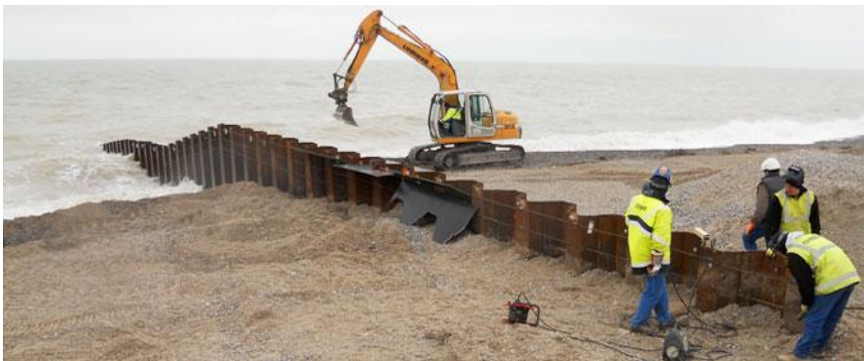
Figure I.5: Les rideaux de palplanches.
