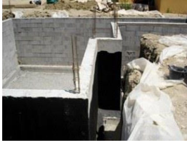
Figure I.14 : drainage du remblai.
